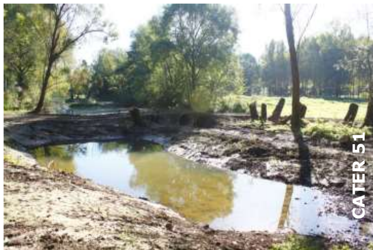
Travaux de la frayère de Condé/Aisne en 2016
