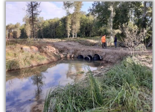
Franchissement de la Vesle
