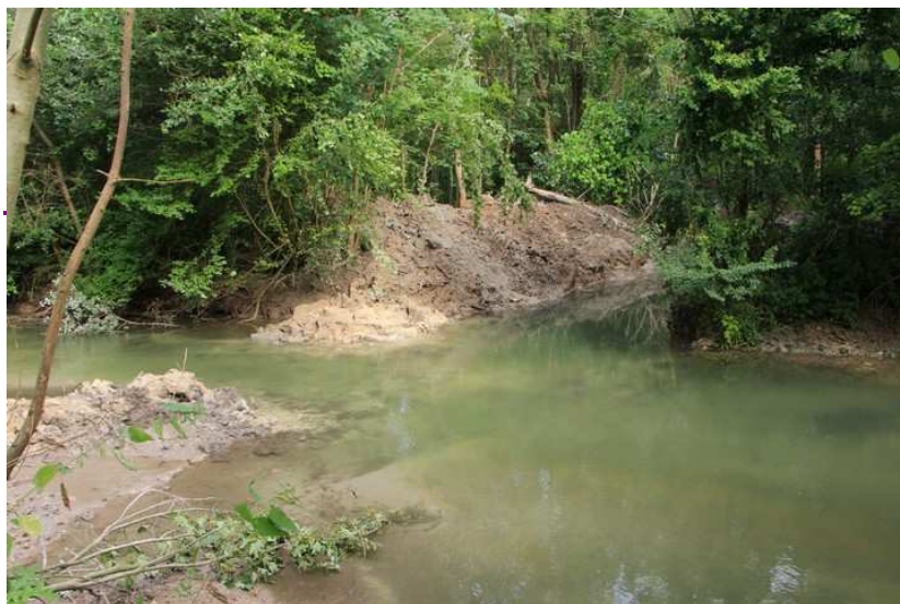
Reconnexion et désenvasement du bras
